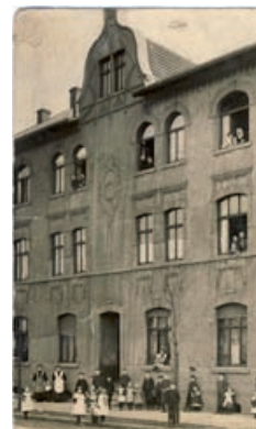
Das Haus Vereinsstraße 7 im Jahre 1910. In der ersten Etage befand sich die Geschäftsstelle des Spar- und Bauverein Wanne.
