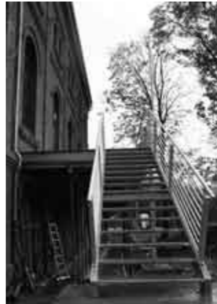
Die neue Eingangsterrasse der Maschinenhalle ermöglicht einen tollen Blick auf den Kanal.
