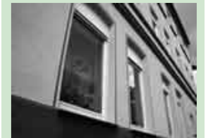
Über 40 Gebäude erhielten dank Fassadenprogramm bereits einen neuen Anstrich.
