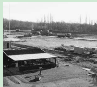
Bauarbeiten auf dem Kohlenlagerplatz
